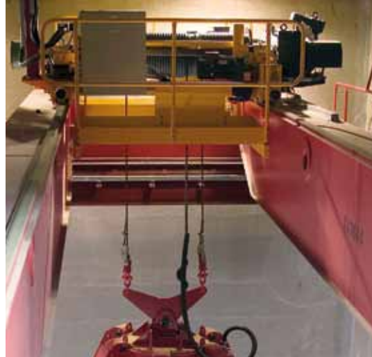
Лейксайд, Великобритания: кран для транспортировки шлама грузоподъемностью 10 тонн
