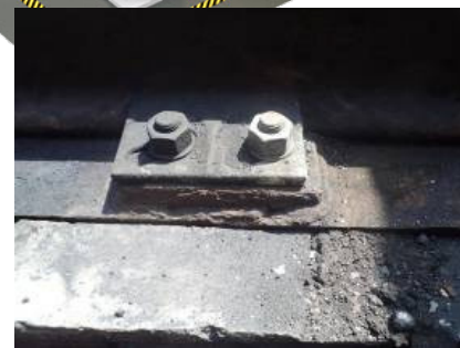
Kiskokiinnikkeiden hitsauksien alkava korroosio.
