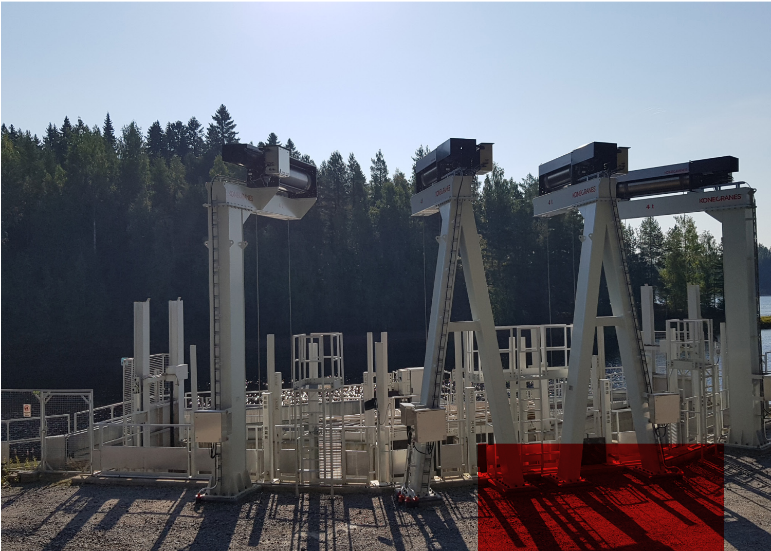
Täysin räätälöity nostoratkaisu koostuu neljästä teräsraakenteisesta pylväsrakenteesta, joihin on jokaiseen kiinnitetty Konecranes CXT-nostinkoneisto.
