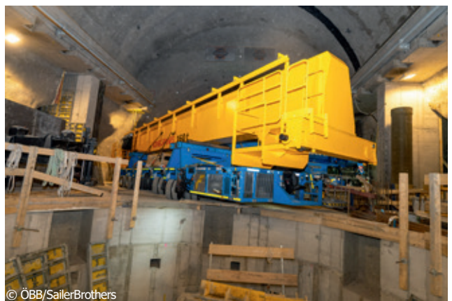
Anlieferung des 160 Tonnen Maschinenhauskrans
