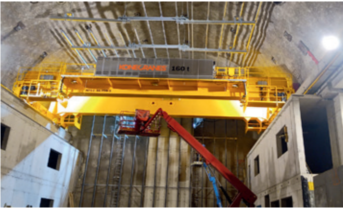
160t Maschinenhauskran in der Kaverne
