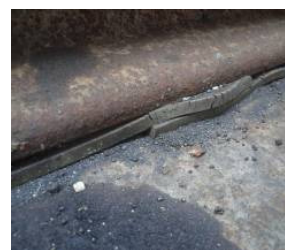
Zwischenlage ist nicht korrekt installiert.
