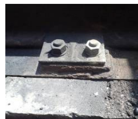
Schweißnähte der Klemmenauflage beginnen zu korrodieren.
