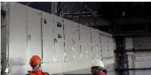
3 Die neuen Komponenten, 4 Montage neue Schaltschränke
